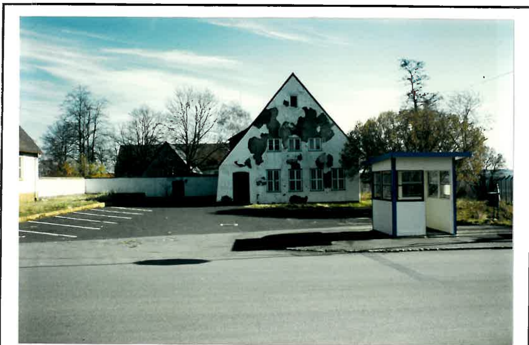
Bild 6 Bauschäden (Gebäude Nr. 2)
