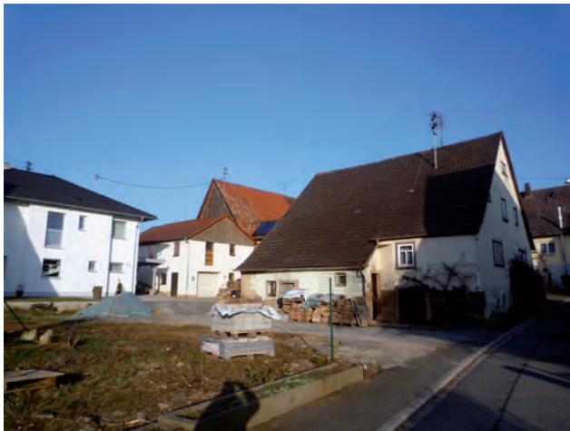
Abb. 60 Scheune (Mitte) und altes Wohnhaus (rechts)
