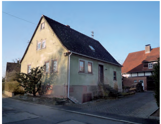
Abb. 43 Wohngebäude mit Sanierungsbedarf
