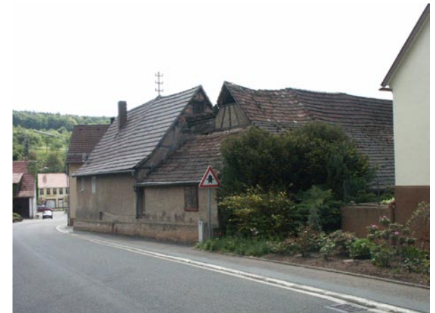
mit hohem Sanierungsbedarf
