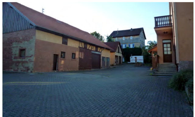
Großflächig versiegelter Hof
