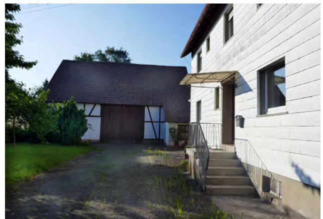
Hof mit Wohnhaus und Scheune
