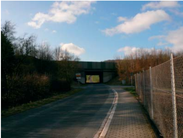
Unterführung unter der Autobahn (Ortsverbindung nach Lindelbach / Verlängerung der Lindelbacher Straße)
