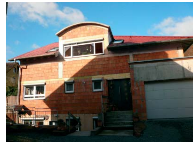
Neubau in der Wirtsgasse mit ortsfremden Gestaltungsmerkmalen
