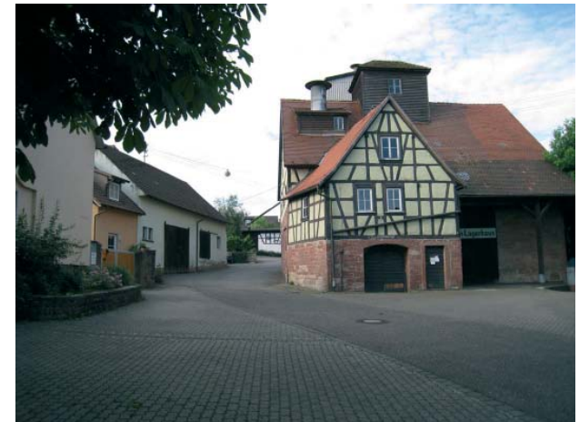
leerstehende Raiffeisengebäude am Zehntplatz
