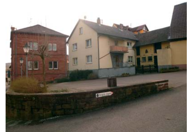
Frei- bzw. Parkfläche mit geringer Aufenthaltsqualität neben der Kirche
