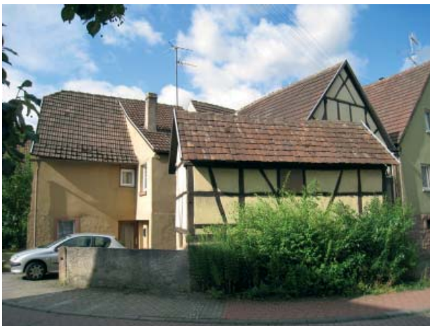
Anwesen Am Oberen Tor 2: Kleinteiliger Gebäudebestand
