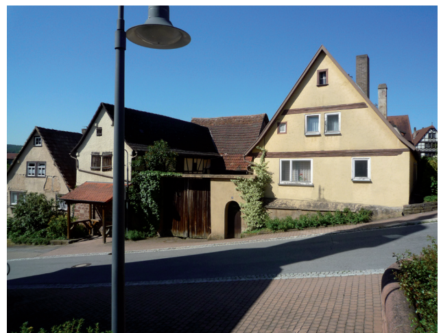
Abb 23: Gebäude in eher schlechtem Erhaltungszustand im Ortskern von Lindelbach
