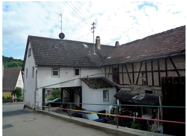
Abb 28: Grundstück mit dichter Bebauung ohne Grünflächen im Ortskern von Lindelbach
