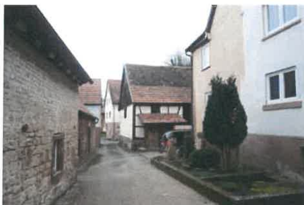
Abb. 46 Kleine Grundstücke, dichte Bebauung, fehlende eigene Erschließung
