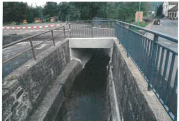
Abb. 13 Verrohrter Bachlauf im Ortsbereich
