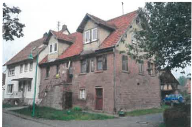
Abb. 45 Ortstypische Bausubstanz, Sanierungsbedarf
