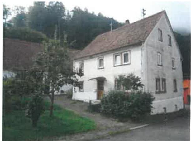
Abb. 40 Leerstehendes Wohnhaus Quellenstraße
