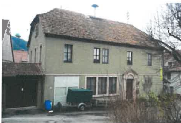
Abb. 18 Denkmalgeschütztes Gebäude mit veränderter Fassade
