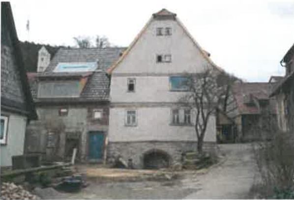
Abb. 57 Rainbachstraße 21 während der Sanierung
